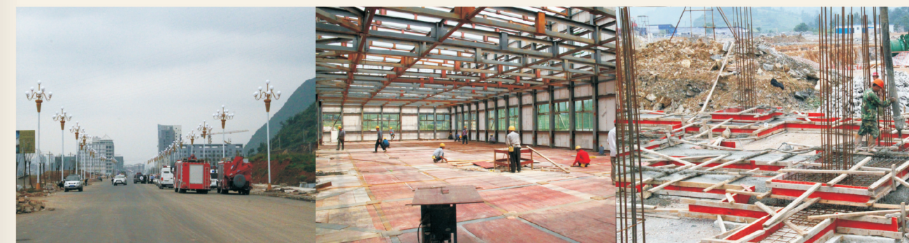
瓮安经济开发区干道路灯安装
